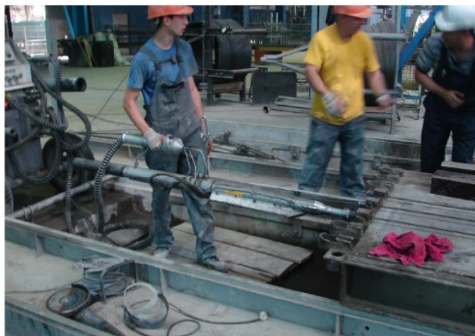
Рисунок 5 – Натяг арматурних канатів гідравлічним домкратом Figure 5 – Tension of reinforcing ropes with a hydraulic jack
