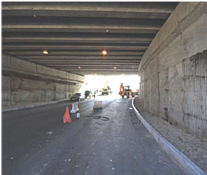
Рисунок 1 – Вид на низ прогонової шляхопроводу тунельного типу розв'язки біля моста Патона. Figure 1 – Bottom view of the tunnel-type span overpass of the interchange near the Paton Bridge
